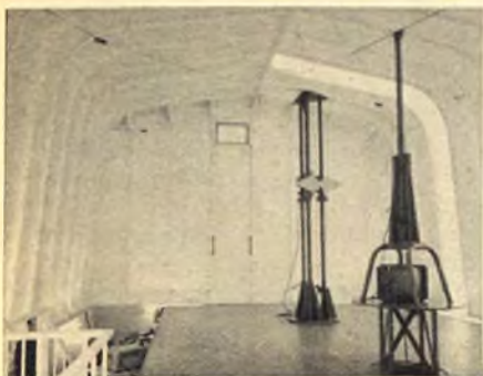
Bild 3. Innenansicht des Meßgebäudes
