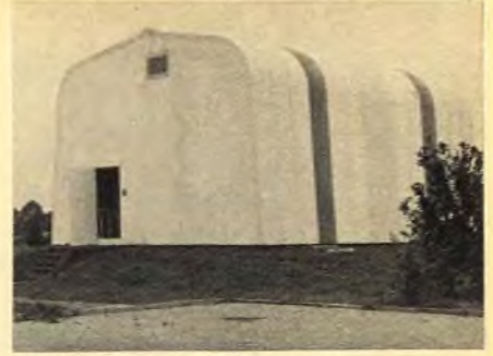
Bild 5 ▶ Außenansicht des Meßgebäudes
